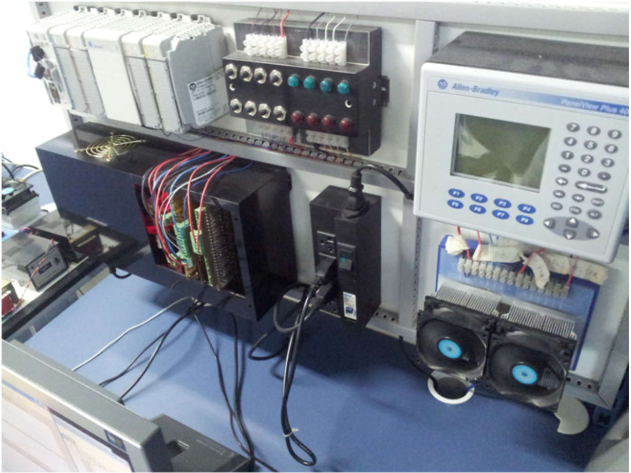
Figura 14: Planta utilizada para o controle
